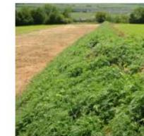
**Fachgerechte Lagerung des Bodens:** Bevor die Leitung verlegt wird, wird der Boden schichtweise abgetragen und auf Mieten angehäuft. So kann der Boden nach Abschluss der Arbeiten schichtweise an seinen ursprünglichen Platz zurücktransportiert werden.
