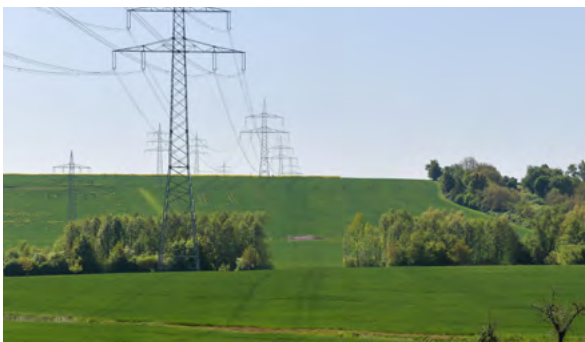
Nach dem Bau
