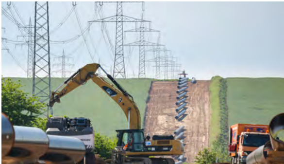
Während des Baus
